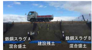
写真1 実物大スラグ混合盛土
