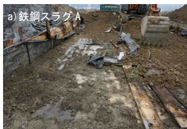
写真6 盛土基盤部の様子 (a: 鉄鋼スラグ A 混合土, b: 鉄鋼スラグ B 混合土)
