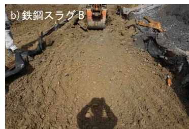
写真6 盛土基盤部の様子 (a: 鉄鋼スラグ A 混合土, b: 鉄鋼スラグ B 混合土)
